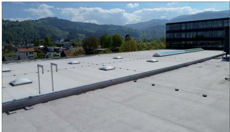
Fig. 3: Panoramica della copertura dell'edificio Meusburger a Wolfurt (Austria)
