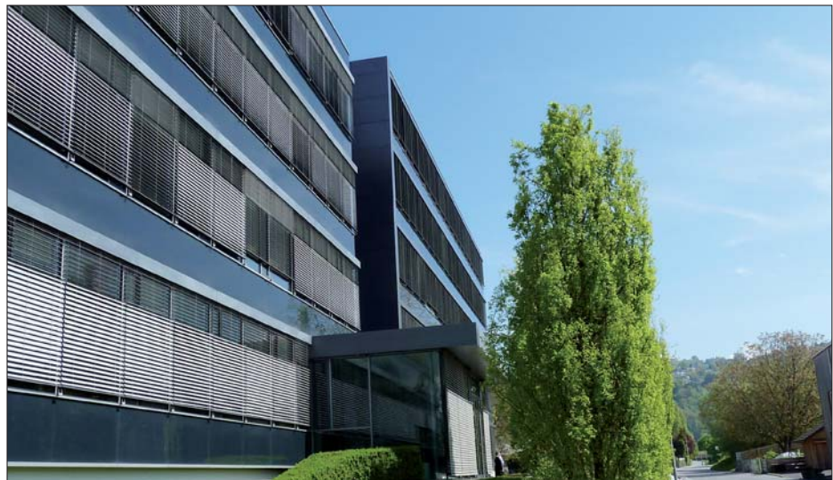
Fig. 2: Vista frontale dell'edificio Meusburger a Wolfurt (Austria)
