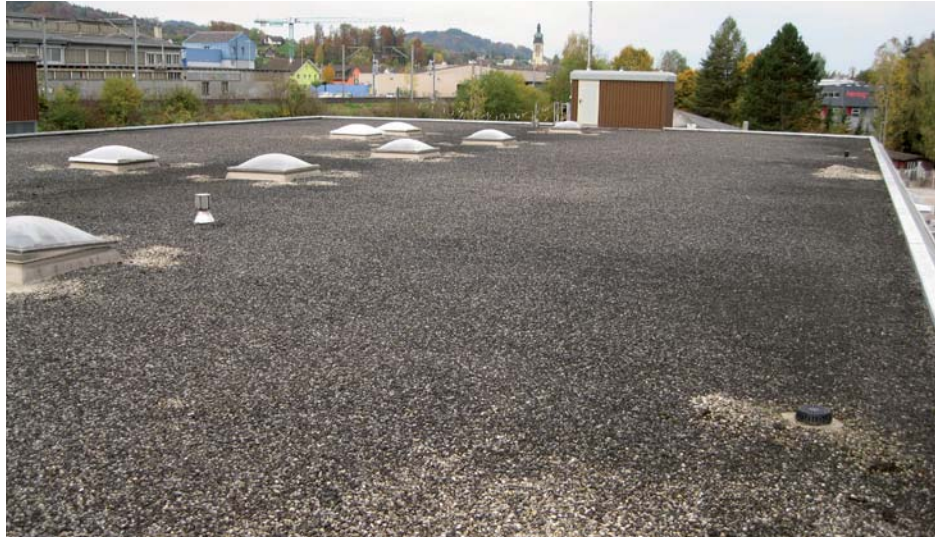
Fig. 4: Panoramica della copertura dell'edificio Brunner a Flawil (Svizzera)
