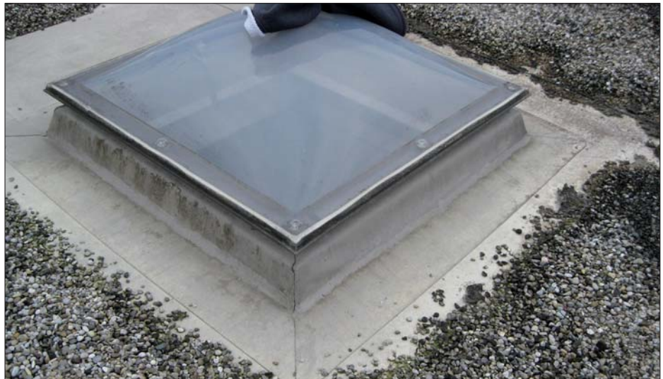
Fig. 5: Raccordo al lucernaio, copertura edificio Brunner a Flawil (Svizzera)
