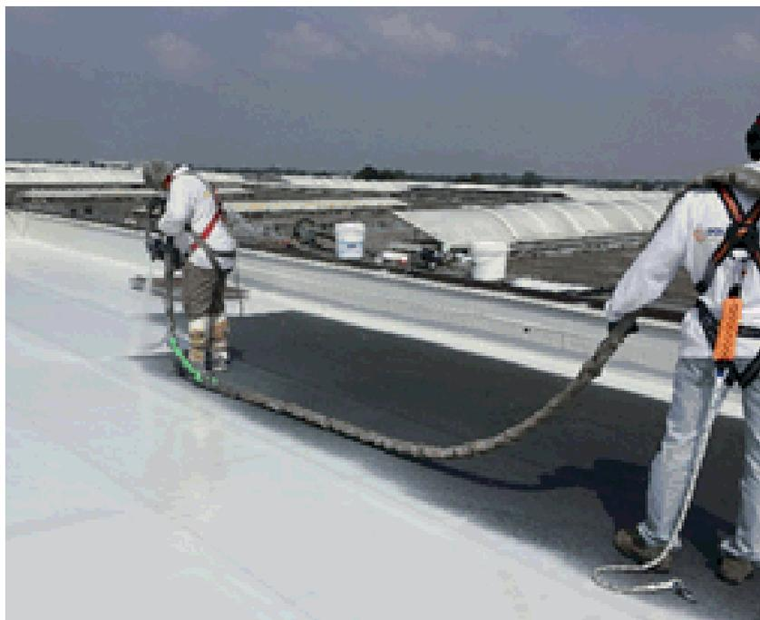
In alcuni casi, il sistema di membrane liquide non solo estende il ciclo di vita del tetto, ma fornisce anche l'opportunità di renderlo più funzionale migliorando l'aspetto estetico del tetto.
