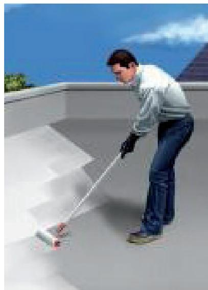
I sistemi ad alta riflettanza, come ad esempio Sikalastic®-621 TC SR (RAL 9016), permettono di realizzare sistemi di copertura "Cool Roof" caratterizzate da una riduzione del surriscaldamento della copertura con conseguente riduzione dei costi di raffrescamento degli edifici. Con i prodotti Sika si possono ottenere elevati vantaggi economici e si può anche migliorare la qualità della vita.
