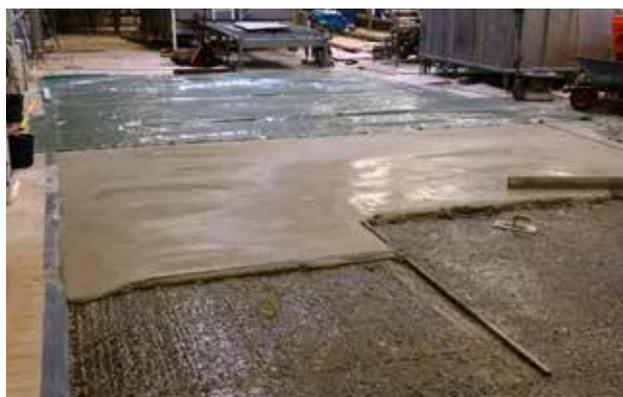
**VENERDÌ SERA:** Applicazione dello strato adesivo e del massetto cementizio Sikafloor® HardTop-80 a presa rapida.
