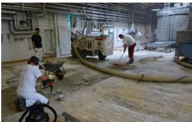
**VENERDÌ POMERIGGIO:** Rimozione meccanica delle vecchie piastrelle e dell'adesivo epidossico. Preparazione e lavaggio del substrato.
