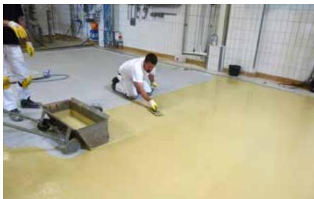
**SABATO POMERIGGIO:** Applicazione del Sikafloor® PurCem® HM-20, pavimentazione ibrida in poliuretano-cemento.
