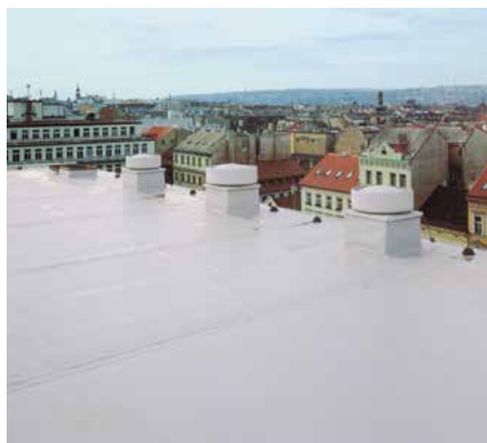
Coperture a vista
